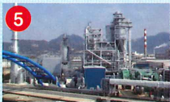
5 防府エネルギーサービス(株) 山口県防府市 発電設備/79,550kW 種類/石炭
