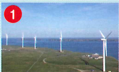
1 JEN昆布盛ウインドファーム(株) 北海道根室市 発電設備/20,000kW 種類/風力
