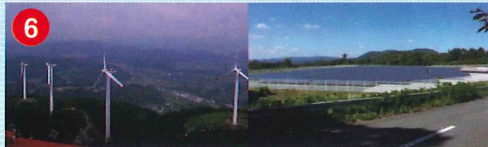
6 JEN玖珠ウインドファーム(株) 大分県玖珠郡 発電設備/12,000kW 種類/風力、太陽光
