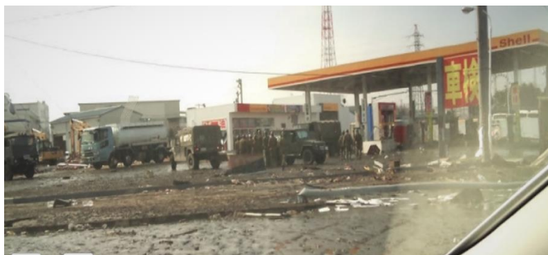
旧仙台港店 震災2日後の写真「場所:県道23号線[産業道路]仙台港交差点」
